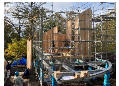
DLT 施工の様子
